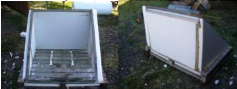
J'ai fait l'ossature légèrement plus petite (78\*92) de manière à emboîter le polystyrène dedans. Plaquer une paroi contre l'ossature, tracer avec un couteau les bord puis enlever la plaque d'isolant. Avec le couteau toujours, découpez les rainures puisque vous avez tracé les bords. Ca se découpe comme dans du beurre. Emboîtez la plaque (Simone viendra après...) et visser. J'utilise des rondelles larges avec les vis pour ne pas casser le plâtre de la plaque.
